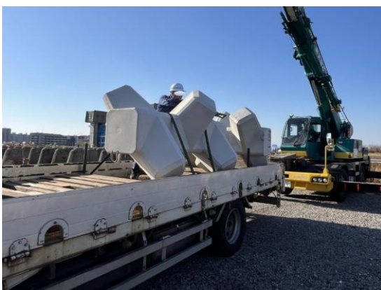
ブロック現場搬入
