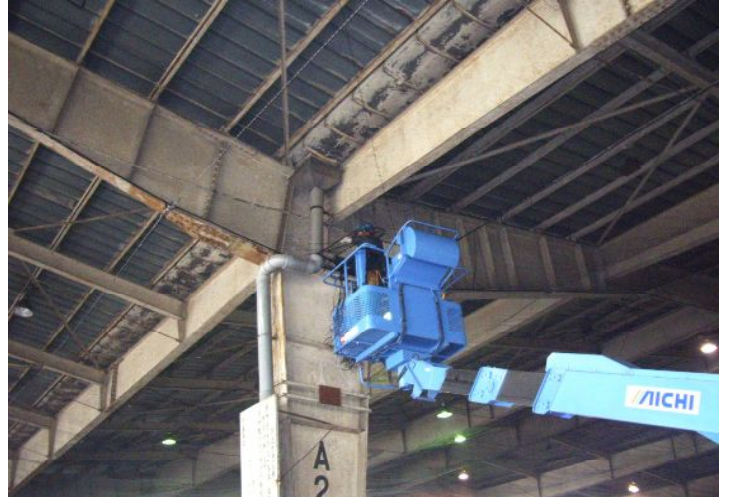
端部及び点検口取り付け中
