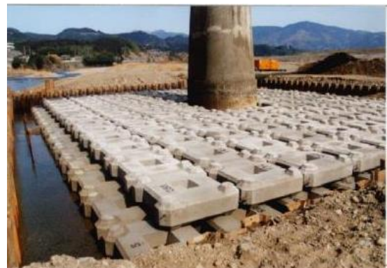
愛媛県大洲市 肱川 (肱川橋) セッカブロック C形4t型 セッカブロック 半割4t型
