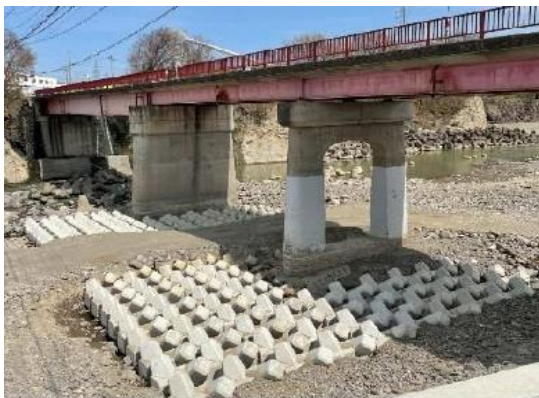
長野県東御市 千曲川（境橋） コーケンブロック 2.0型 × 4単位 (8t級)
