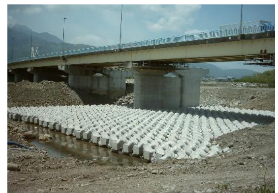
山梨県韮崎市 塩川（新塩川大橋） コーケンブロック 2.0型 × 3単位 (6t級)
