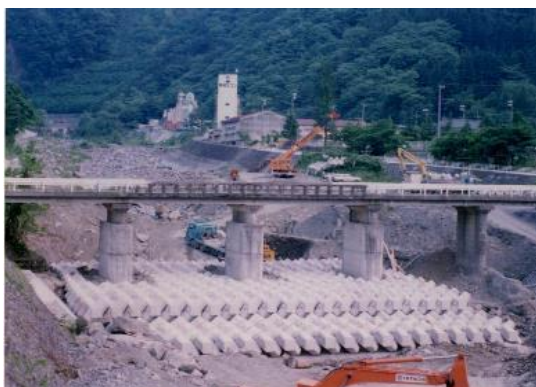
山梨県南巨摩郡早川町 春木川 コーケンブロック 2.0型 × 4単位 (8t級) コーケンブロック 2.0型 × 5単位 (10t級)
