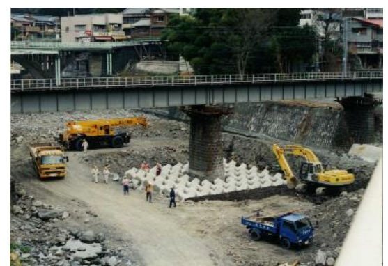
静岡県富士宮市 芝川（芝川橋梁） コーケンブロック 3.0型 × 4単位 (12t級) コーケンブロック 3.0型 × 5単位 (15t級)
