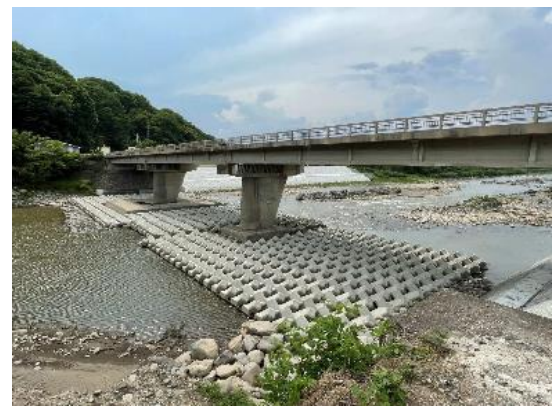
長野県東御市 千曲川（田中橋） コーケンブロック 2.0型 × 4単位 (8t級)
