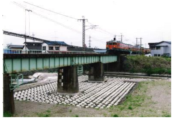
群馬県伊勢崎市 粕川（国定・伊勢崎間粕川橋梁） コーケンブロック 0.5型 × 3単位 (1.5t級) コーケンブロック 0.5型 × 4単位 (2t級) コーケンブロック 0.5型 × 5単位 (2.5t級)
