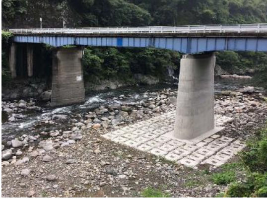
群馬県みどり市 渡良瀬川 (新栄橋) セッカブロック C形3t型・半割3t型
