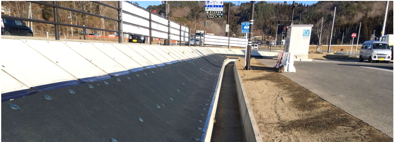
道の駅駐車場防草対策
