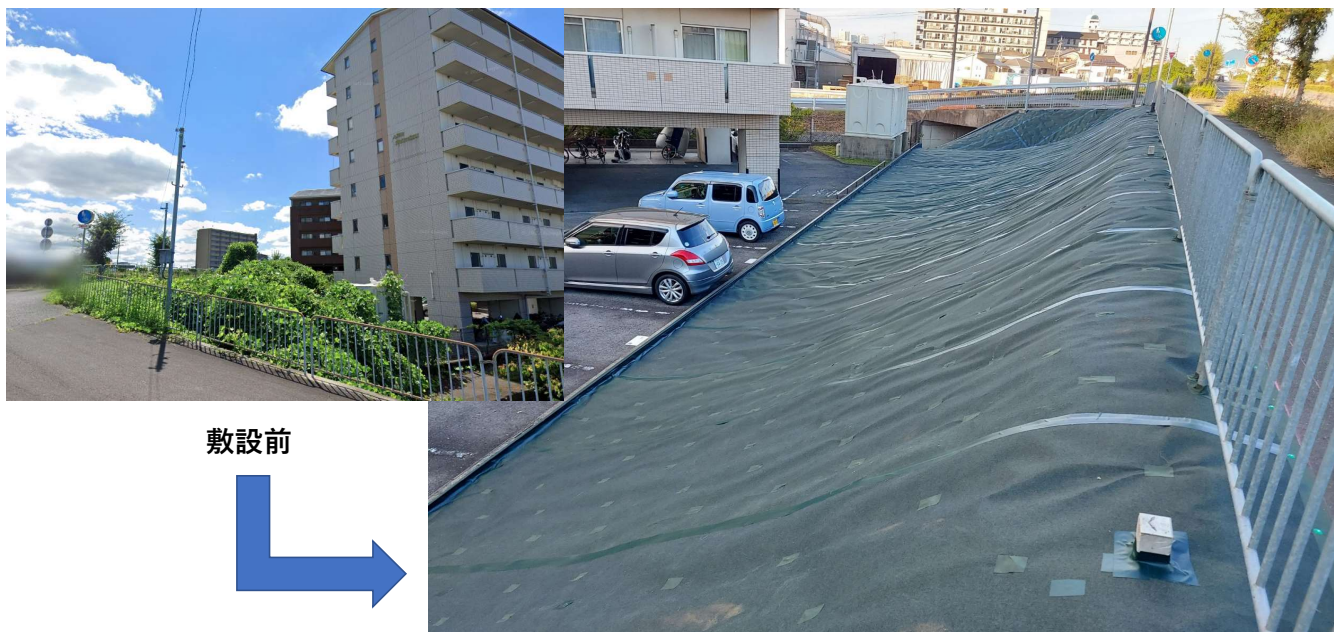
バイパス側道法面防草対策
