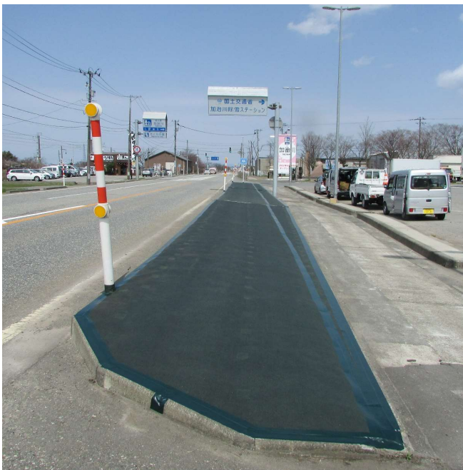
道の駅植樹帯防草対策
