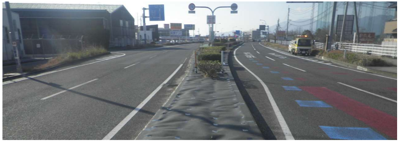
中央分離帯防草対策
