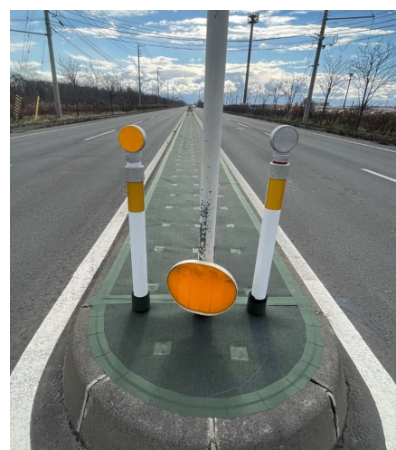
中央分離帯防草対策
