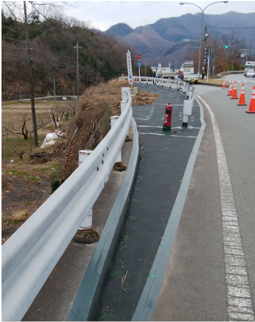
交差点側道脇防草対策
