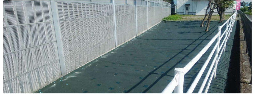
防災倉庫防草対策
