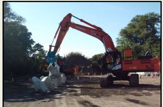
④ブロックを降ろす
