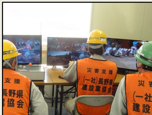
離れた場所でモニターを見ながらコントローラーで操作しています
