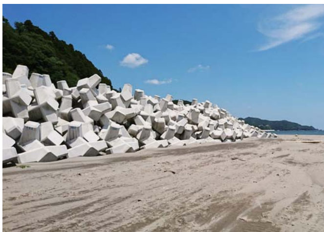
宮城県 新北上川 根固工 L2.0型 × 2単位 乱積
