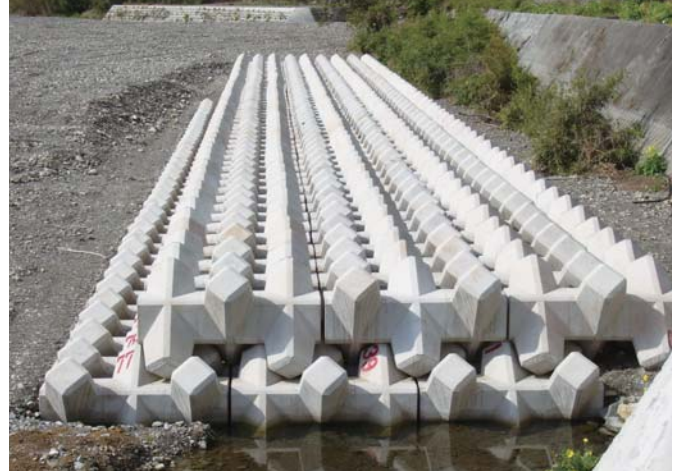
高知県 新莊川 根固工 1.0型 × 3単位 小空隙配列
