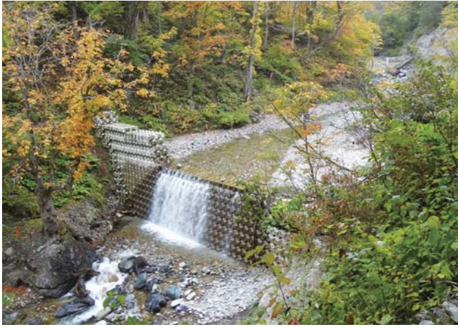
福島県 安越岐川 谷止工 0.25型 × 3,4,5単位
