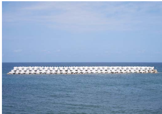
富山県 下新川海岸(建設海岸) 離岸堤工 8.0型 × 3,4単位 大空隙配列
