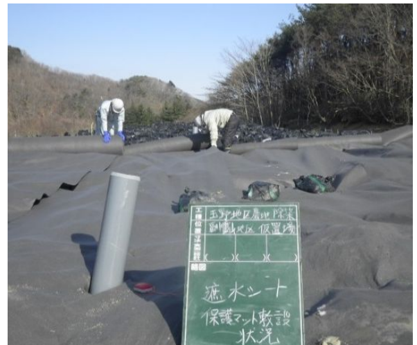
不織布保護のための遮水シート敷設状況
