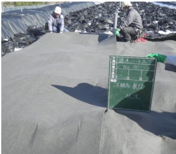
フレコン上部への不織布敷設状況
