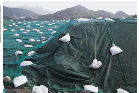
(風対策でネットと土のうを使用)
