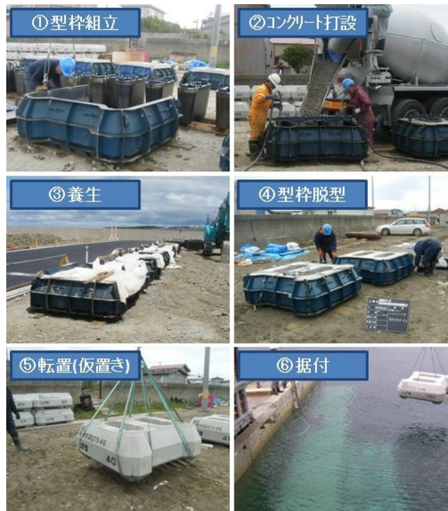
アレトエイトの施工写真
